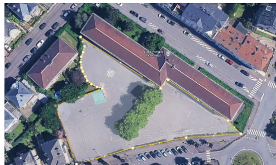
Vue aérienne de la cour de l'école primaire Victor Hugo de Thionville. Source : Google earth
